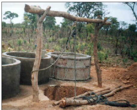
Ein Brunnen entsteht
