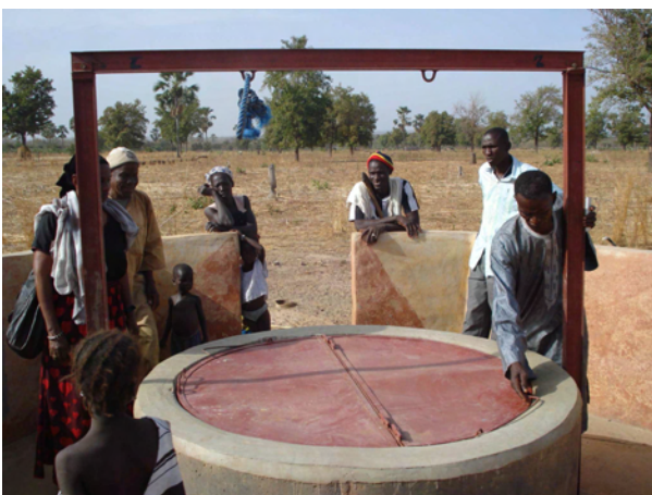
Trinkwasserbrunnen in Sélinkégni – bei Kita
